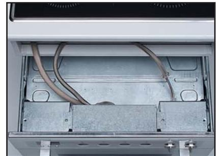
8. Empuje el horno hacia dentro y sujételo al mueble con los 2 tornillos (Figura 2) que encontrará en la bolsa de accesorios del horno.
