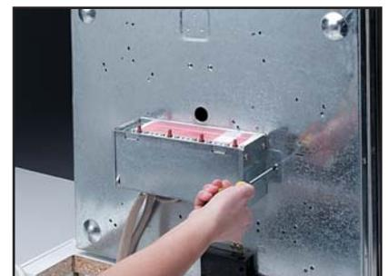
4. A continuación deberá instalar dicha placa en el hueco de la encimera. Teniendo en cuenta que la caja de conmutadores queda colgada de la placa. Cumpla correctamente los requisitos de instalación de la placa (ver manual de instalación de la placa).
