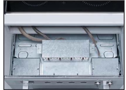
6. Introduzca el cable en el conector del horno.
